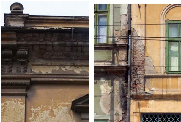
GREȘIT! Jgheaburi și burlane de evacuare a apei meteorice defecte duc la degradări masive ale fațadelor.
