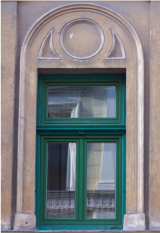
CORECT! Tâmplăria ferestrelor este realizată din lemn, cu geamuri termopan, respectându-se modelul istoric.
