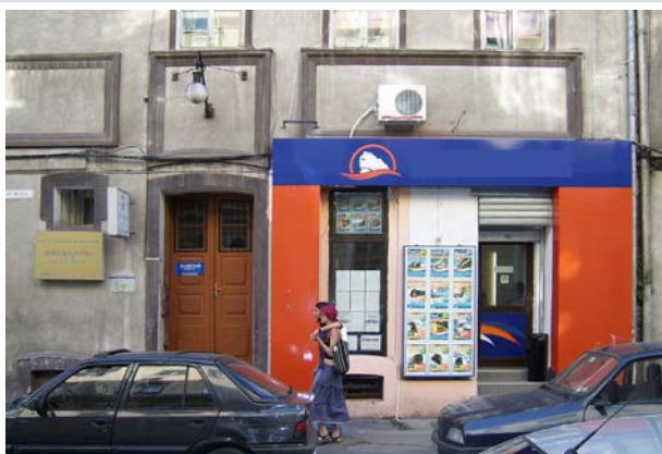
GREȘIT! Firma magazinului acoperă elemente constitutive ale fațadei. Ea nu se potrivește nici ca material și nici cromatic cu fațada istorică.
