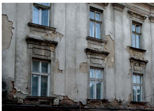
MARE PĂCAT! Fațadele degradate și ornamentele distruse iremediabil afectează foarte negativ aspectul clădirilor istorice. Ele duc și la deteriorări grave ale zidăriei, care nu mai este protejată împotriva intemperiilor.
