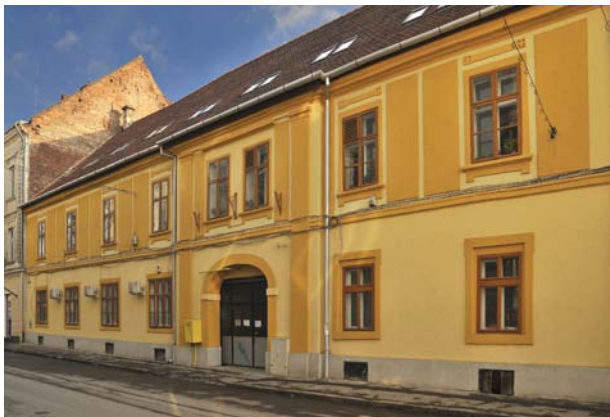
CORECT! Fațada a fost tratată corect, cu mortar de var. Paleta cromatică, culorile fațadei, sunt de asemenea reușite.
