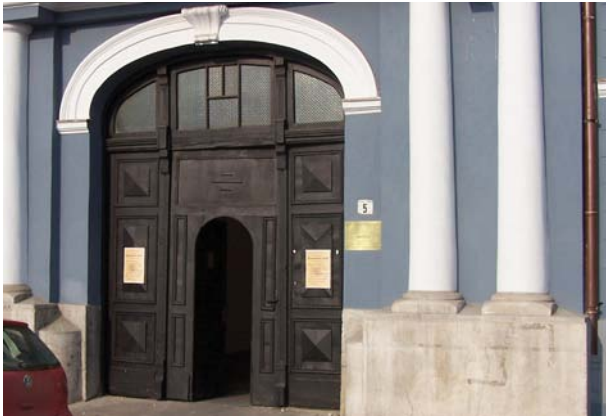
Deseori, porțile mari au o porțiță de acces pentru persoane. Porțița se poate deschide și închide ușor, fără a mai acționa și poarta masivă.
