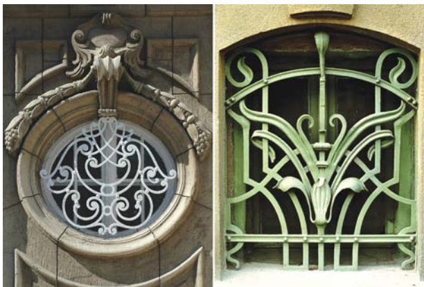
Este obligatoriu ca feroneria executată meșteșugit din zonele istorice din Timișoara să fie păstrată și restaurată
