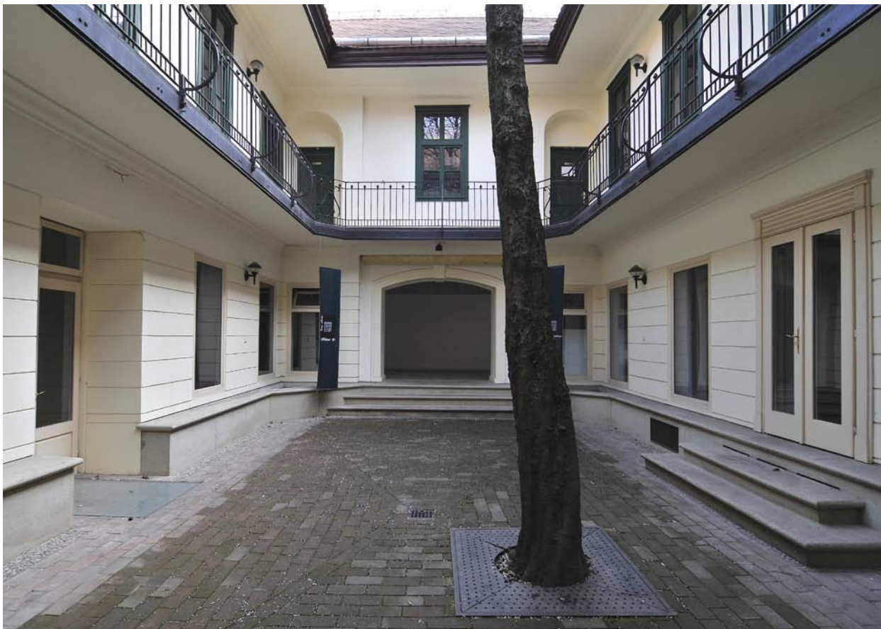
CORECT! Curte interioară exemplar restaurată în cartierul Cetate. Pavajul este executat din cărămizi. Elemente metalice perforate asigură o irigare suficientă a copacului din curte.
