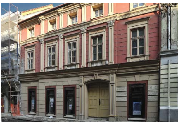
CORECT! Vitrinele restaurate corect se încadrează atât ca proporții, cât și cromatic, în ansamblul fațadei istorice.
