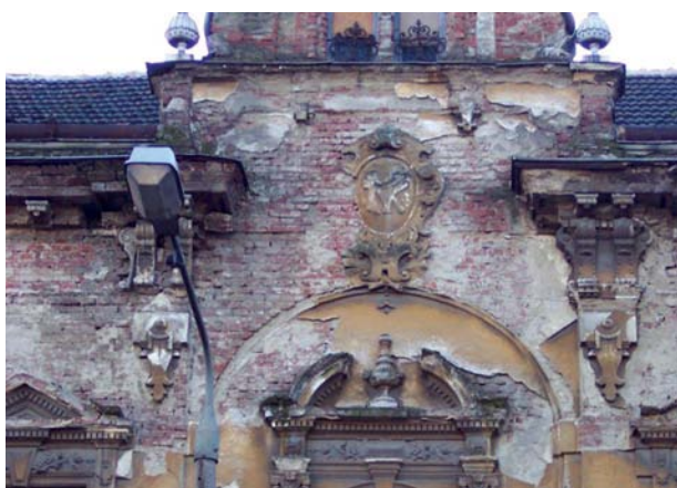
MARE PĂCAT! Fațadele degradate și ornamentele distruse iremediabil afectează foarte negativ aspectul clădirilor istorice. Ele duc și la deteriorări grave ale zidăriei, care nu mai este protejată împotriva intemperiilor.
