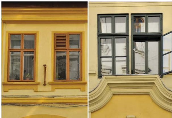
Ferestre istorice simple, de tip "casetă". Canatul exterior al ferestrei se deschide către exterior.
