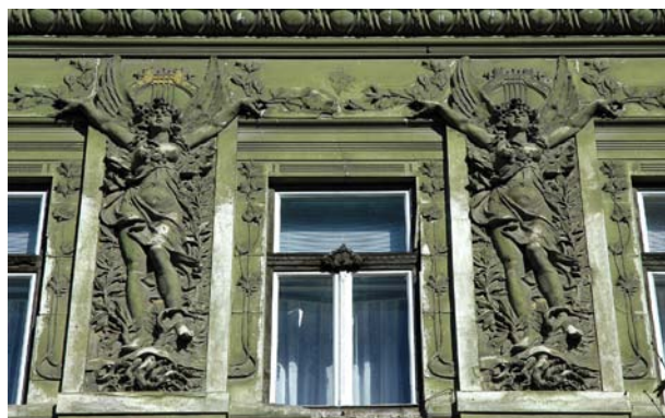
MARE PĂCAT! Fațadele degradate și ornamentele distruse iremediabil afectează foarte negativ aspectul clădirilor istorice. Ele duc și la deteriorări grave ale zidăriei, care nu mai este protejată împotriva intemperiilor.
