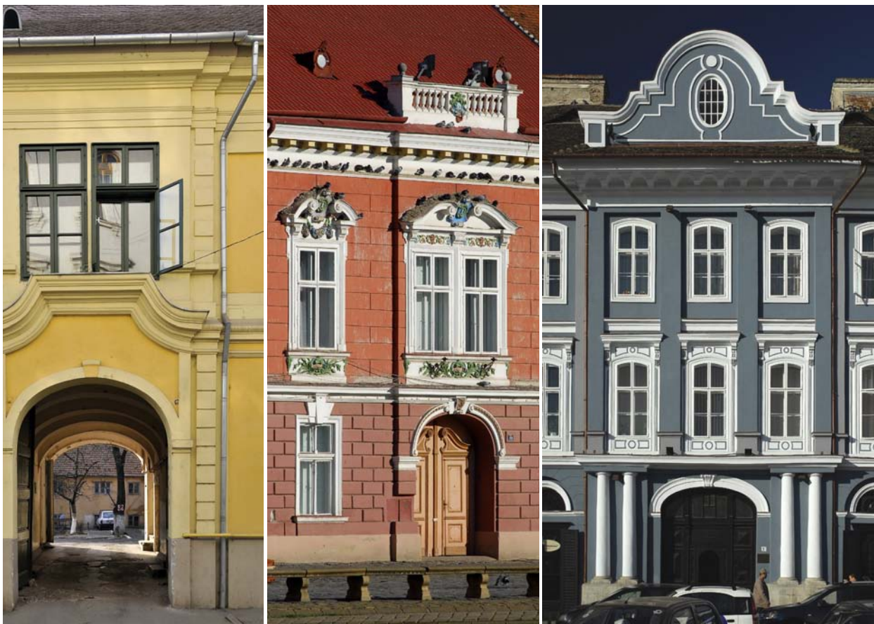
Façade restaurate exemplar în zonele istorice ale Timișoarei.
