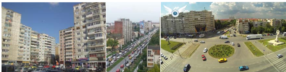
Fig. 14. Blocuri de locuințe construite în perioada comunistă în Timișoara
