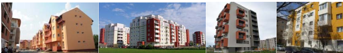
Fig. 17. Microansambluri rezidențiale cu clădiri multietajate sau cu blocuri reabilitate
