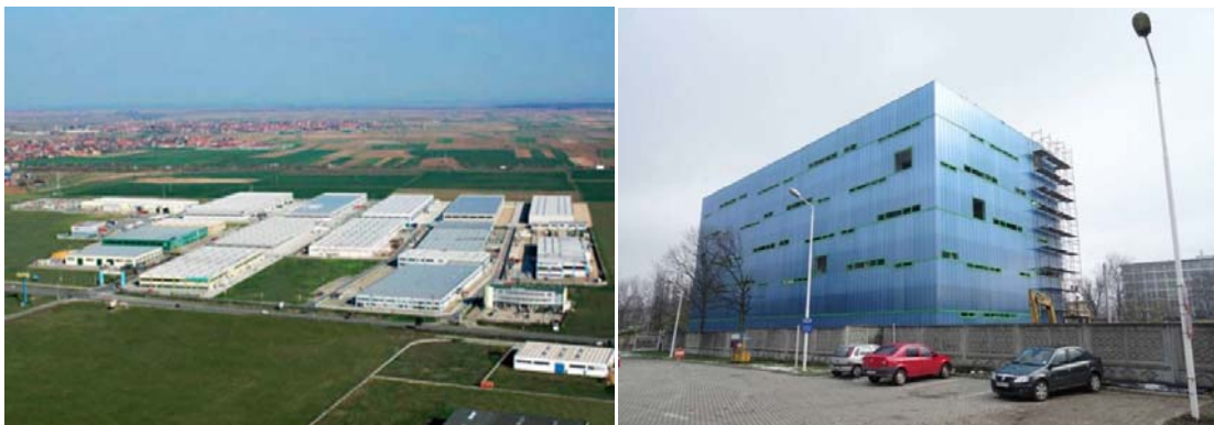
Fig. 26. Parcul industrial și tehnologic (PIT) și Incubator, Timișoara
