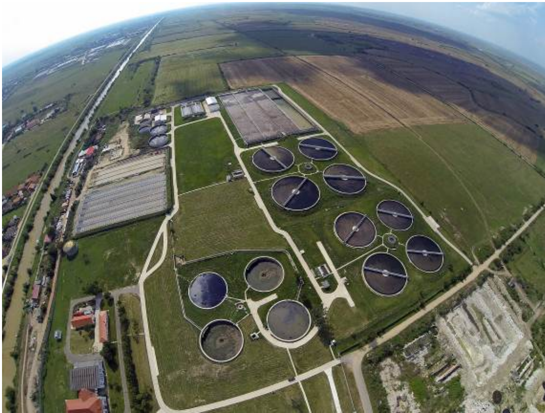
Foto: Vedere aeriană a Stației de Epurare „Stan Vidrighin” din Timișoara
