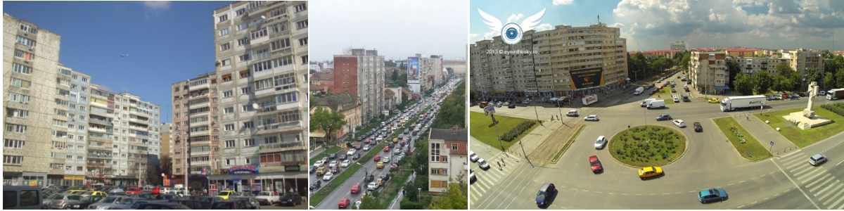
Fig. 14. Blocuri de locuințe construite în perioada comunistă în Timișoara
