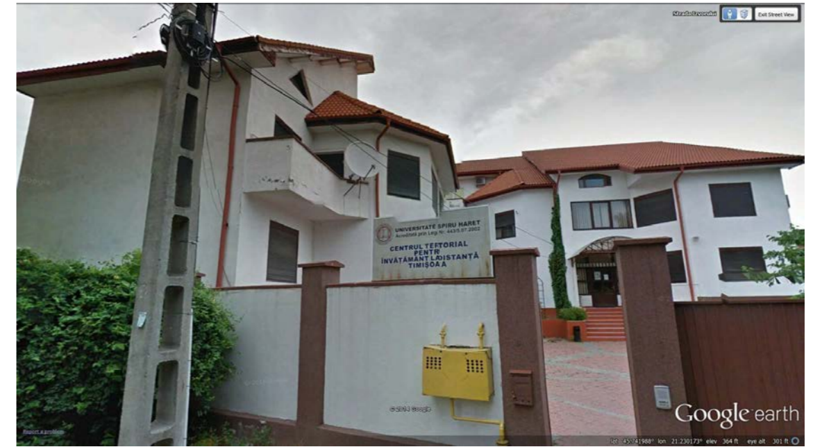
CLADIRE DE PE STR IZVORULUI CU CALCAN DE 13M SPRE PARCELA STUDIATA
