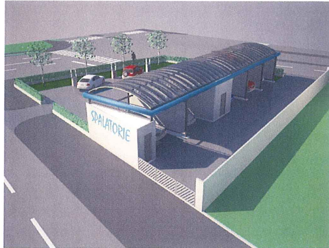
VEDERE STRADA LIDIA V4
