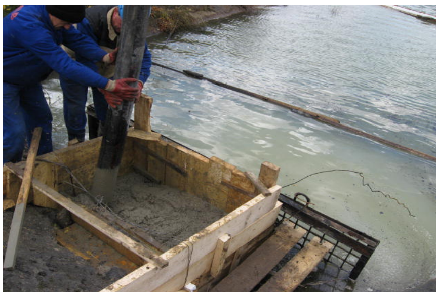
Balta Subuleasa – blindarea conductei de deversare
