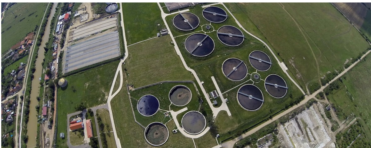
Foto: Stația de Epurare „Stan Vidrighin” din Timișoara
