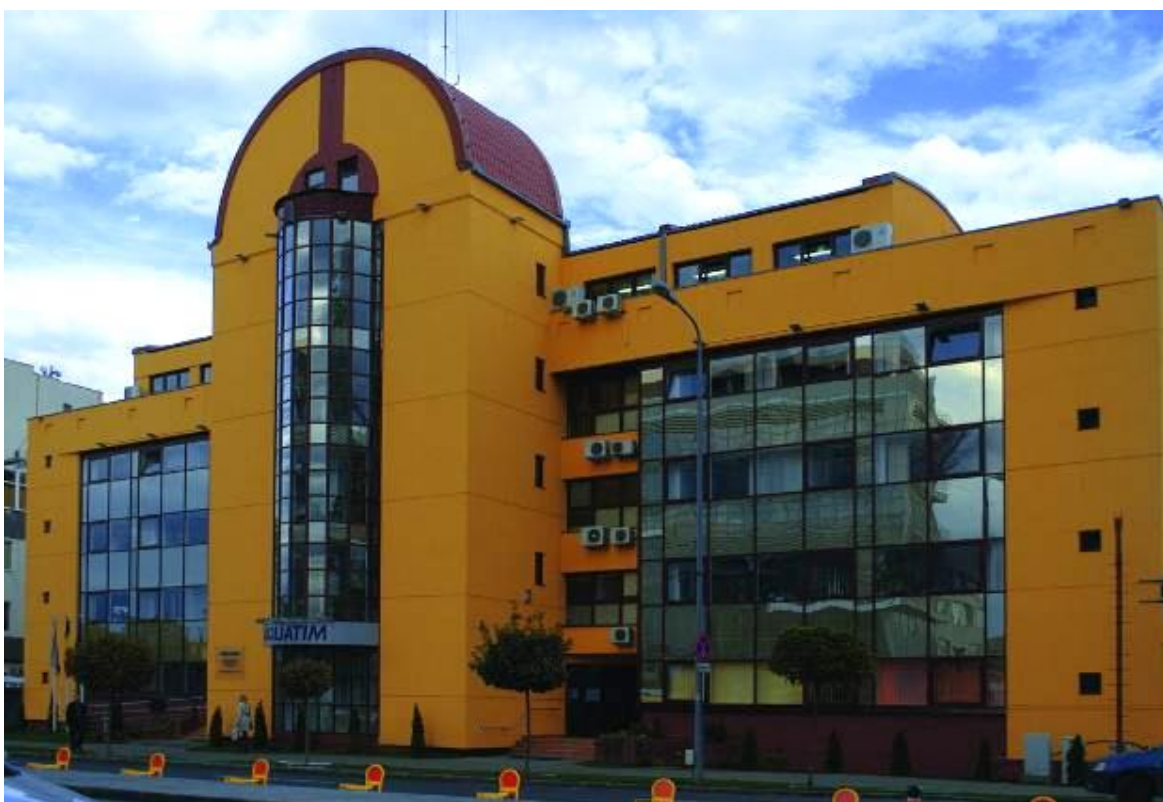
Foto Sediul central Aquatim din Timișoara
