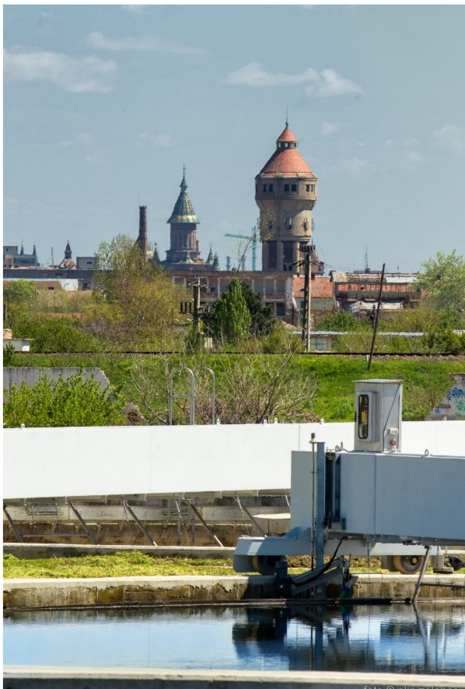
Foto: Imagine de la Stația de Epurare „Stan Vidrighin” din Timișoara
