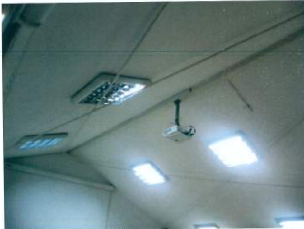
Foto nr. 6. Corp P+1 – Structură metalică etaj (sală „Amfiteatru”)
