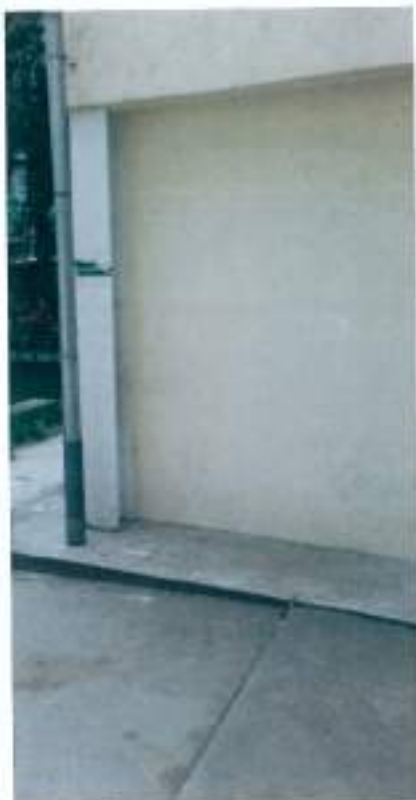
Foto nr. 1. Stâlp de colț – corp P+1
