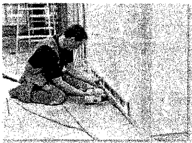
5. Fixarea profilului inferior de început.
