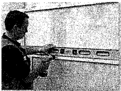
1. Amplasarea șipcilor în spatele introducerii de distanțiere.
