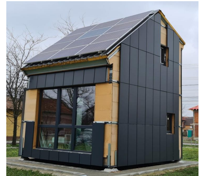
Laboratorul modular mobil în timpul fazei de construcție
