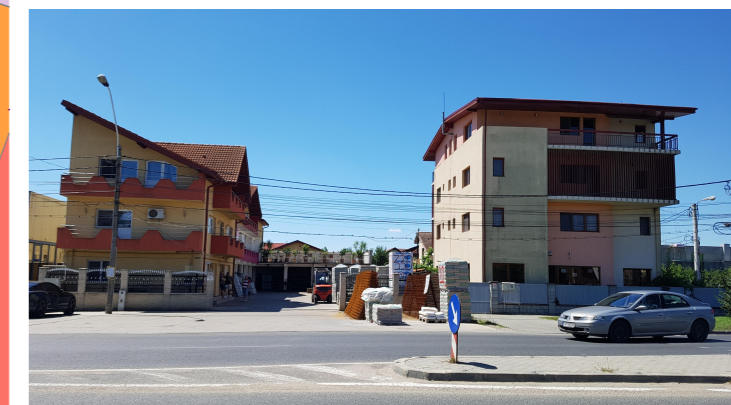
FOTOGRAFIE EXISTENT - CLĂDIRI P+3, P+2E SITUATE ÎN DREAPTA LOTULUI STUDIAT
