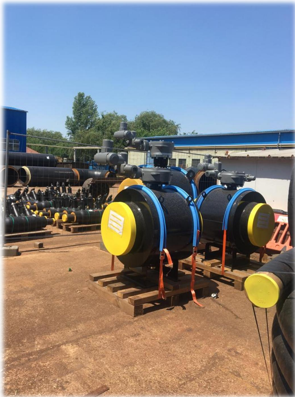
Organizare șantier - Retehnologizare rețele termice primare
