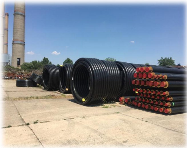
Organizare șantier - Retehnologizare rețele termice primare
