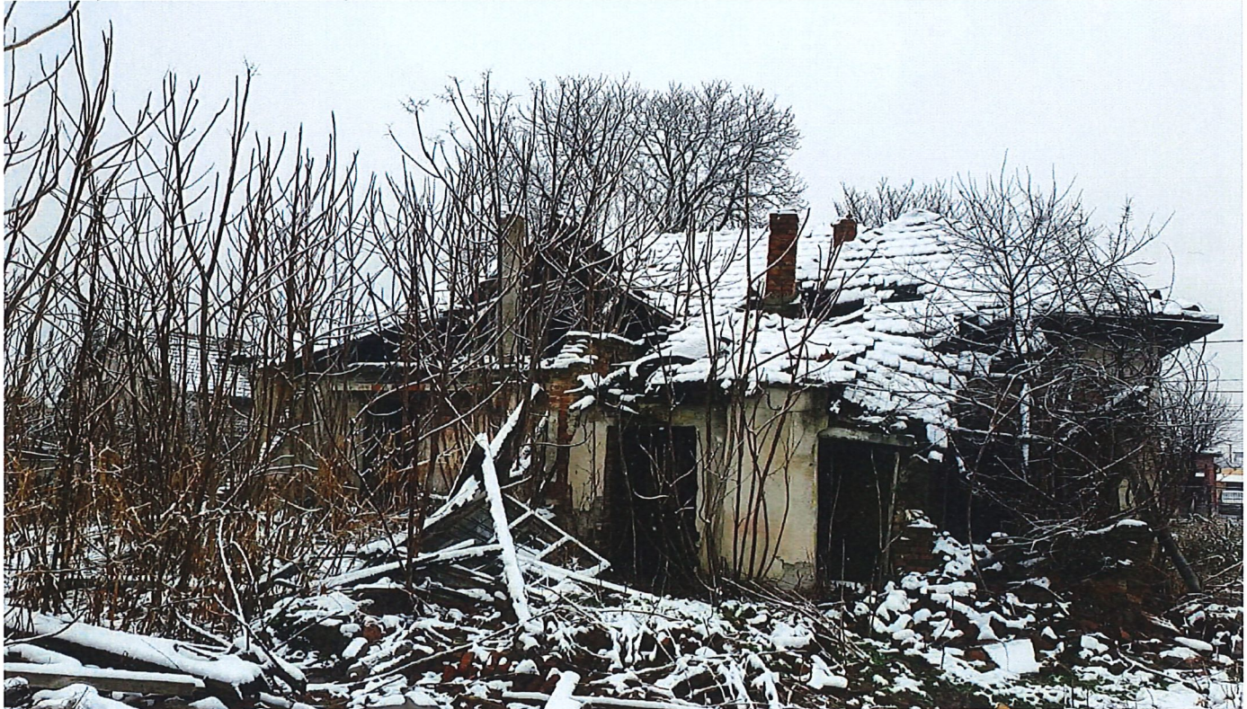
Anexa propusa la demolare
