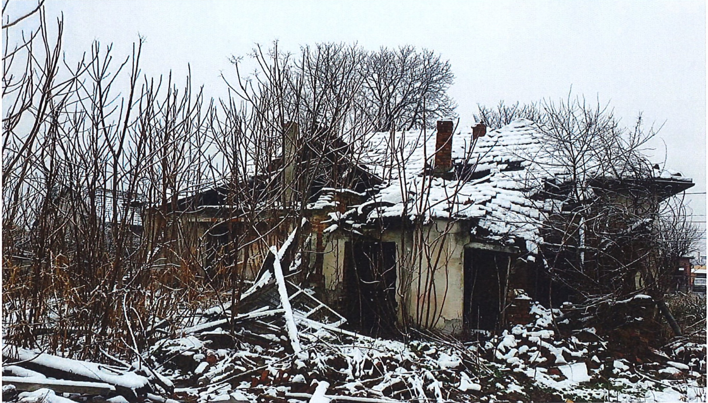
Anexa propusa la demolare
