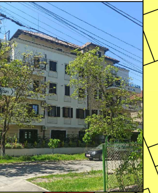
LOCUINTE COLECTIVE REGIM DE INALTIME P+3E SI POT 40-50% EDIFICARE INAINTE DE ANUL 1990
